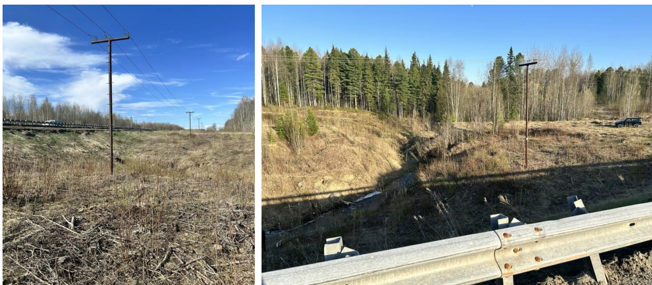
Рисунок 3 – Зона воздушной линии электропередачи с порубочными остатками вдоль автодороги (фото авторов)
