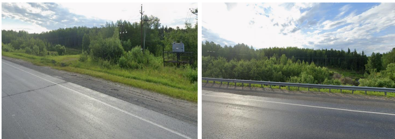
Рисунок 2 – Заросшие растительностью участки воздушной линии (ВЛ) вдоль автодороги (фото авторов)
