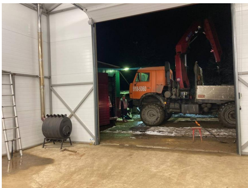
Рис. 2 - Выполнение грузоподъемных работ манипулятором в ангаре
