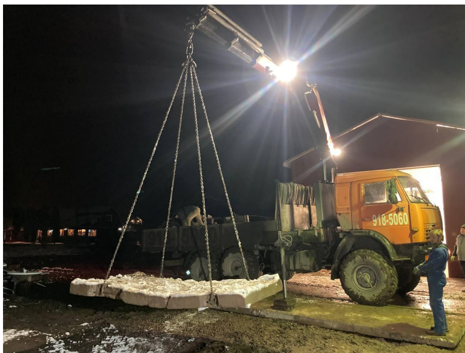
Рис. 3 - Выполнение работ манипулятором на болотистых территориях
