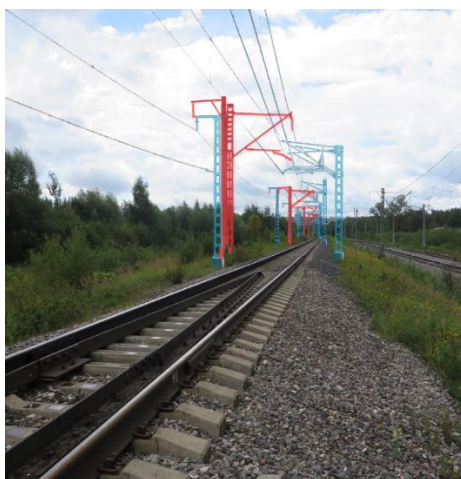
Рисунок 3 – Разбивка опор контактной сети при помощи технологии дополненной реальности
