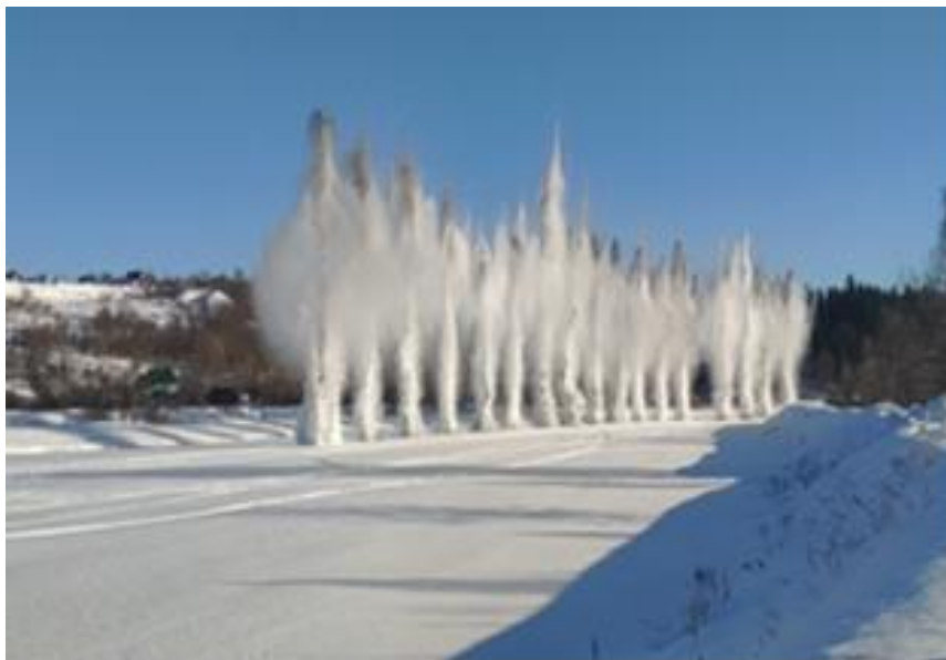
Рисунок 1 – Ледовзрывные работы
