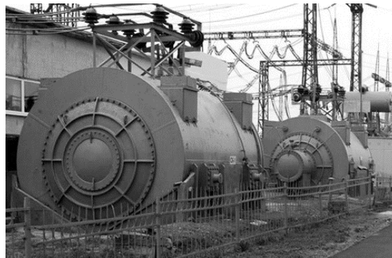
Рис. 2. Синхронный компенсатор
