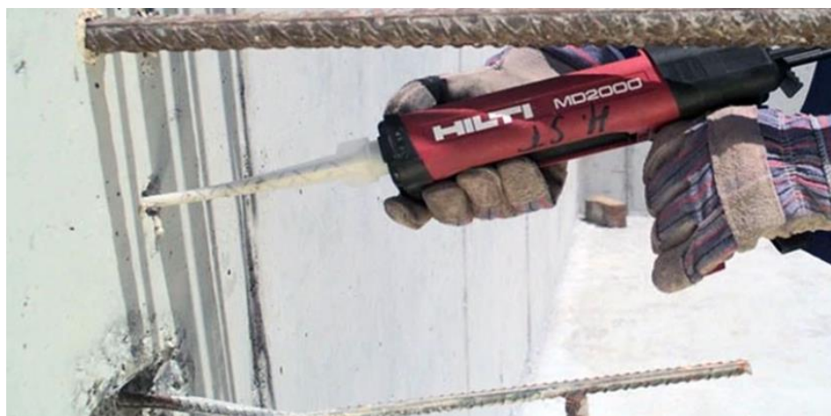
Рисунок 4 - Химический анкер фирмы HILTI
