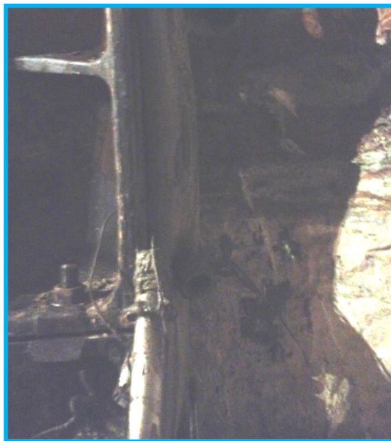
Рис.1. Расположение опорного рукава между кольцом тубинговой крепи и породным массивом
