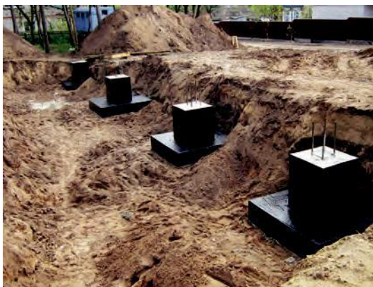
Рис. 2. Пример системы прокладок и стойки
