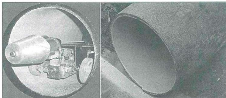
**Рисунок 1.** Распылительная головка передвижного ремонтного модуля (слева) и внутренняя поверхность трубы после нанесения полимерного покрытия
