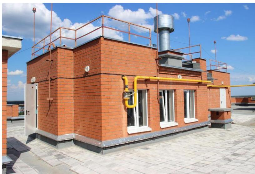
Рисунок 2 – Встроенная (стационарная) крышная котельная
