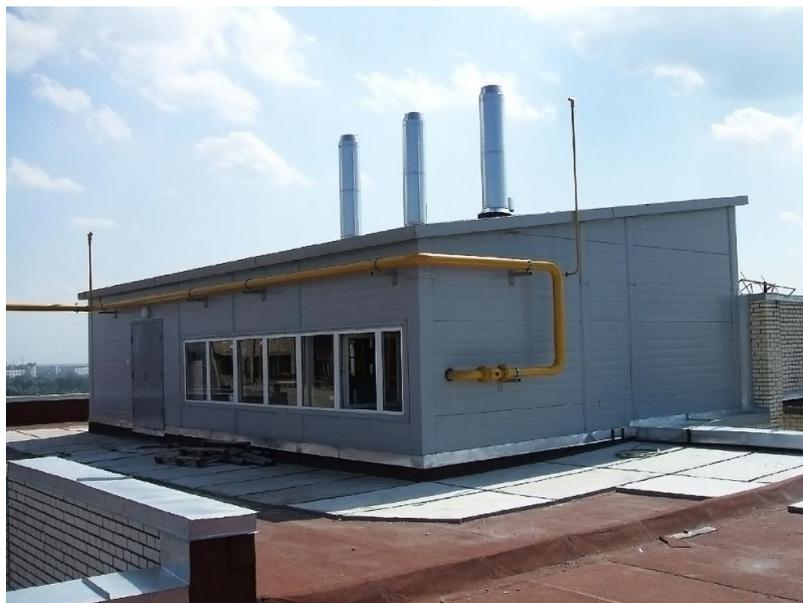
Рисунок 1 – Блочно-модульная крышная котельная
